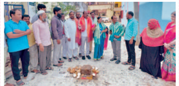
సిసి రోడ్డు పనులకు శ్రీకారం చుడుతున్న కార్పొరేటర్ పుష్పనగేష్
